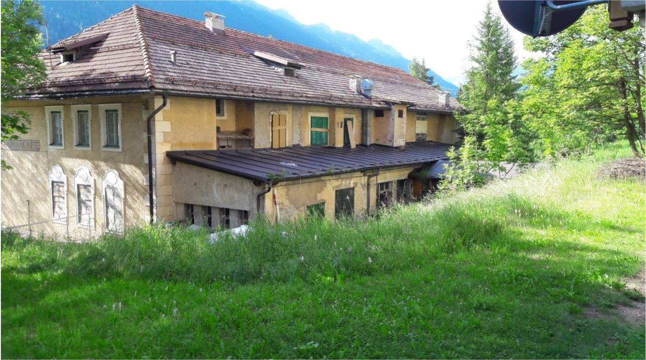
Figura 7: Fronte ovest con il terzo ampliamento dell'ex Caserma corrispondente al corpo basso alto un piano e individuato dalla colorazione verde negli schemi successivi che si ritiene potenzialmente sopraelevabile al fine dell'ampliamento della superficie utile
